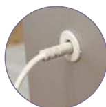
Système de passe-câble
